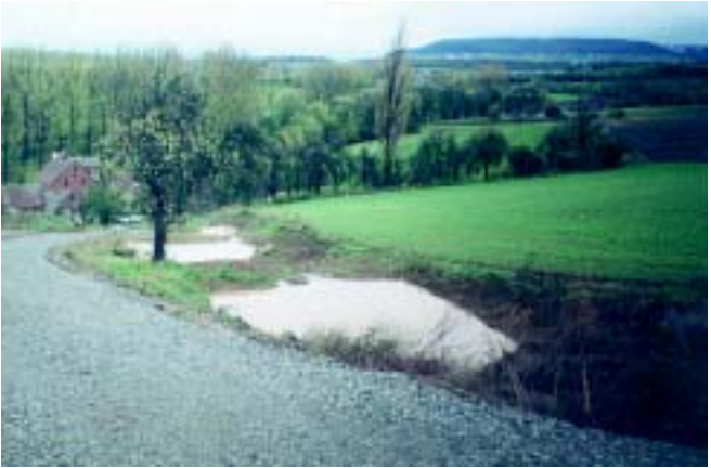
Künstlich angelegter Muldenspeicher im Rahmen der Flurneuordnung zur Sedimentablagerung
